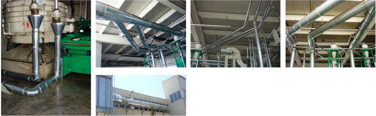
Slika 3 Novi usisni dio cjevovoda
